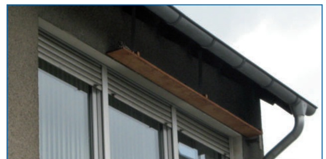
Abb. 4: Dieselbe Kolonie am 13.11.08 mit einem fachgerecht angebrachten Schutzblech. Foto S. SALLERMANN
