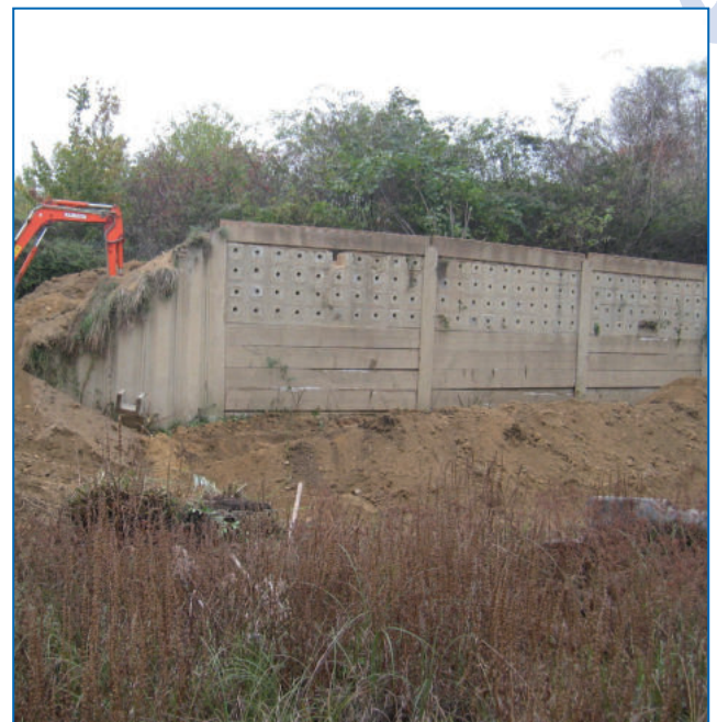
Abb. 3: Die künstliche Uferschwalbenwand an der Profilstrasse im Industriegebiet Unteres Lennetal. Auf dem Bild ist zu sehen, wie der Lehm Boden hinter den Betonfertigteilen ausgetauscht wird. Die Vorderseite der Wand wird jedes Jahr mit einer Lehmschlämpe eingestrichen. So ist dann eine bessere Einbindung in die Landschaft gewährleistet. Störender Weidenaufwuchs wird zurückgeschnitten. 24.10.2003, Foto S. SALLERMANN
